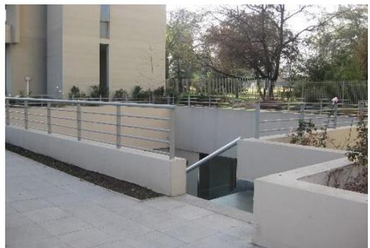
**LOSA Y/O CUBIERTA PLANA TRANSITABLE**
