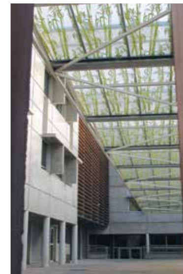
Universidad Bessou, Béziers | Acristalamiento: Estampado de 16 mm de Danpalon® | Arquitecto: MPM Architects
