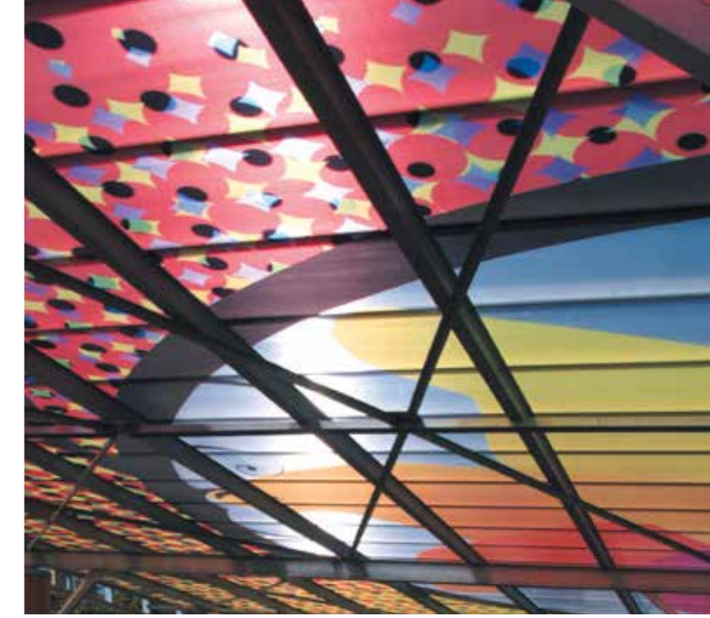
Escuela Secundaria P. Mendes, Arques, Francia Acristalamiento: Estampado Danpalon® Arquitecto: Soupey Toth Architect
