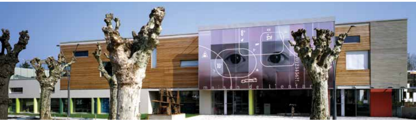
Guardería, Francia | Acristalamiento: Danpalon® Estampado de 16 mm | Arquitecto: Weber y Albrech
