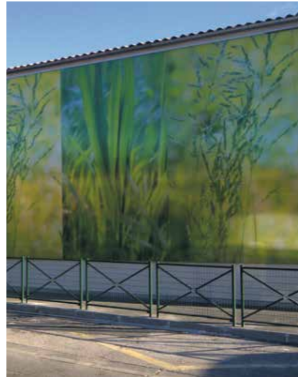
Colegio Santoni, La Garde, Francia Acristalamiento: Danpalon® Estampado de 16 mm Arquitecto: La Garde, Becker Sylvie
