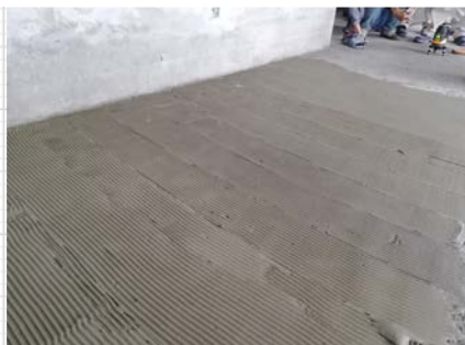
Encolado del soporte
