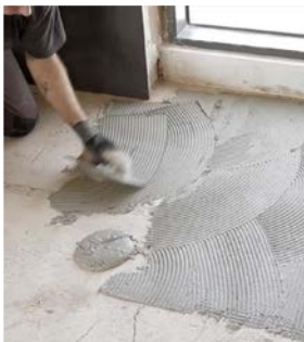
Encolado del soporte
