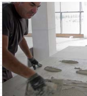
Encolado de la tabla
