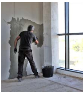
Encolado del soporte
