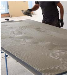
Encolado de la tabla
