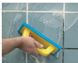
Llanas de rejuntado.
