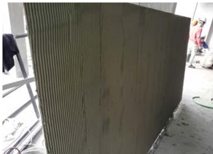
Encolado de la tabla
