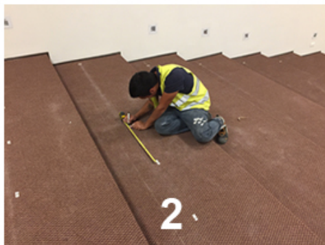
TRAZADO Y PERFORADO SEGUN PLANIMETRIA
