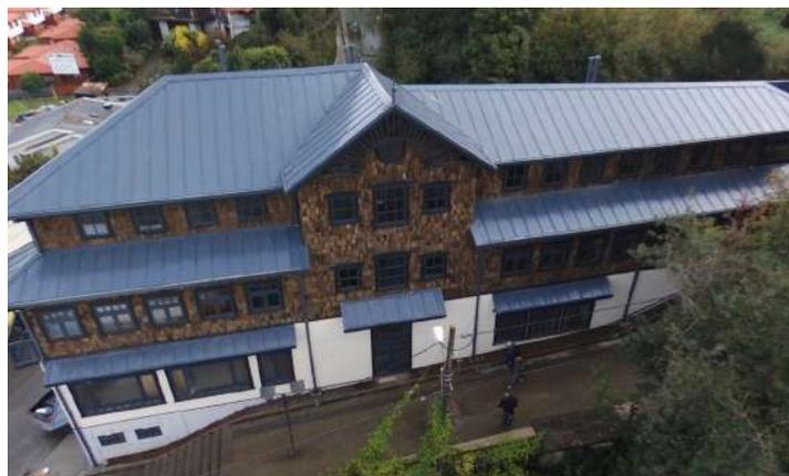
La cubierta click arquitecho es un producto innovador de reciente introducción al mercado, que se caracteriza por ser de fácil y rápida instalación, debido a que no es necesario ocupar máquinas especiales para fijar las planchas a la cubierta en sí.
