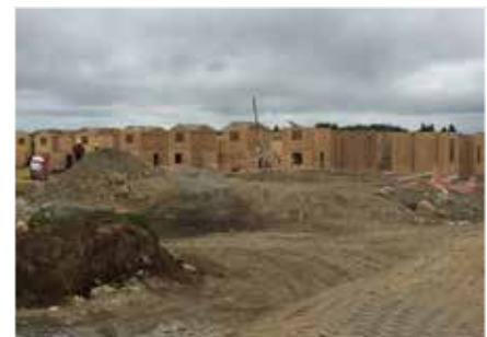
Casa Alta Esperanza Color blanco / Puerto Montt Constructora Baquedano
