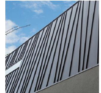
Es esencial que los paneles cónicos compensen los lados opuestos para lograr la formación de paneles paralelos, asegurando una disposición coherente y uniforme.
